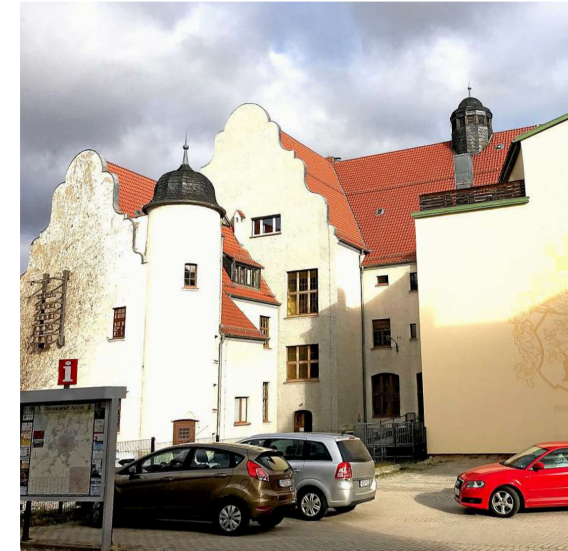
An der Rückfront des Apoldaer Stadthauses, das im Jahre 1913 entstand, wird im Zuge der Sanierung ein Treppenhaus ange stellt.
