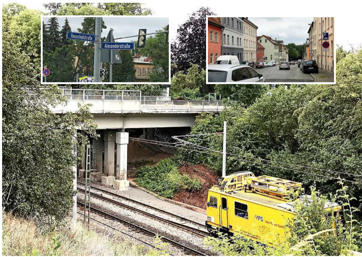
An der Goethebrücke in Apolda (großes Bild) muss in den kommenden Jahren neu gebaut werden. Die Kreuzung Reuschelstraße-Alexanderstraße (kleines Bild links) muss dabei mitgedacht werden. Die Dr.-Theodor-Neubauer-Straße (kleines Bild rechts) soll auch saniert werden. Auch sie würde als Umleitungsstrecke dienen. FOTOS (3): DIRK LORENZ-BAUER
