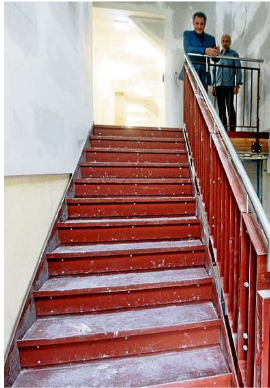
Erste und dringendste Sanierungsmaßnahme – nach der behördlichen Schließung des Dachgeschosses 2011 in der Pestalozzischule – war der Einbau einer zweiten Fluchttreppe vom Obergeschoss in die unteren Etagen im letzten Jahr. FOTO: SASCHA MARGON
