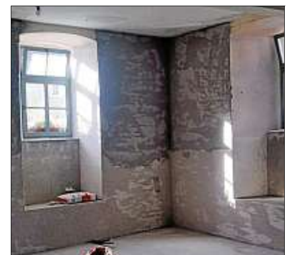
Noch in der Sanierung befindet sich der Ratssaal in Bad Sulza. Die Wände sind frisch verputzt, der Fußboden betoniert. In der ersten Jahreshälfte hatte Heizungswasser alles geflutet. Foto: Verwaltung
